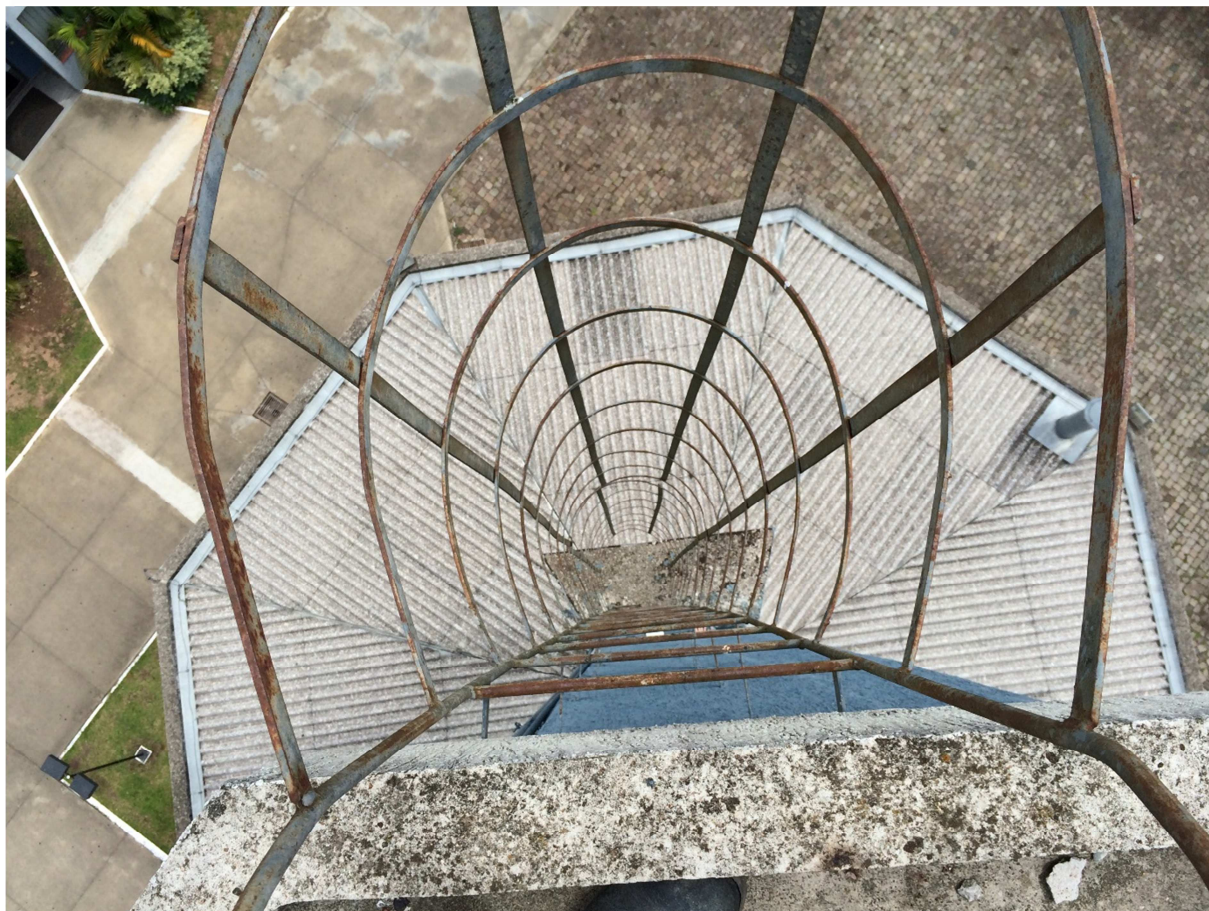
(Escada marinheiro – Acesso externo)
