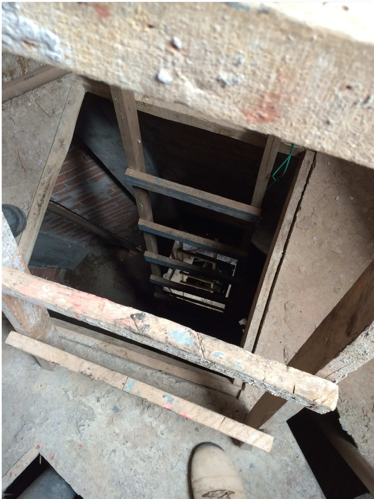
(Acesso precário através de escadas de madeira)
